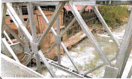
LA ESTRUCTURA DONDE TOMAMOS ESTA FOTO PUENTE CHIMBA LOS CIMIENTOS ESTAN EN PELIGRO, SE OBSERVA A LA DERECHA COMO SOCAVA UN COLEGIO
