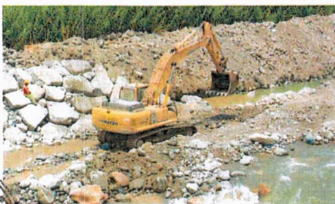
PROTECCION DE LAS TOMAS DE CAPTACION DE AGUA POTABLE CON ENTOCADO
